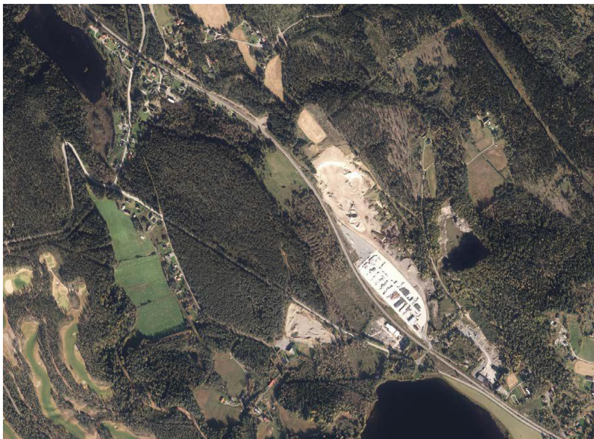
Figur 8: Flyfoto av terminalområdet i Granli
